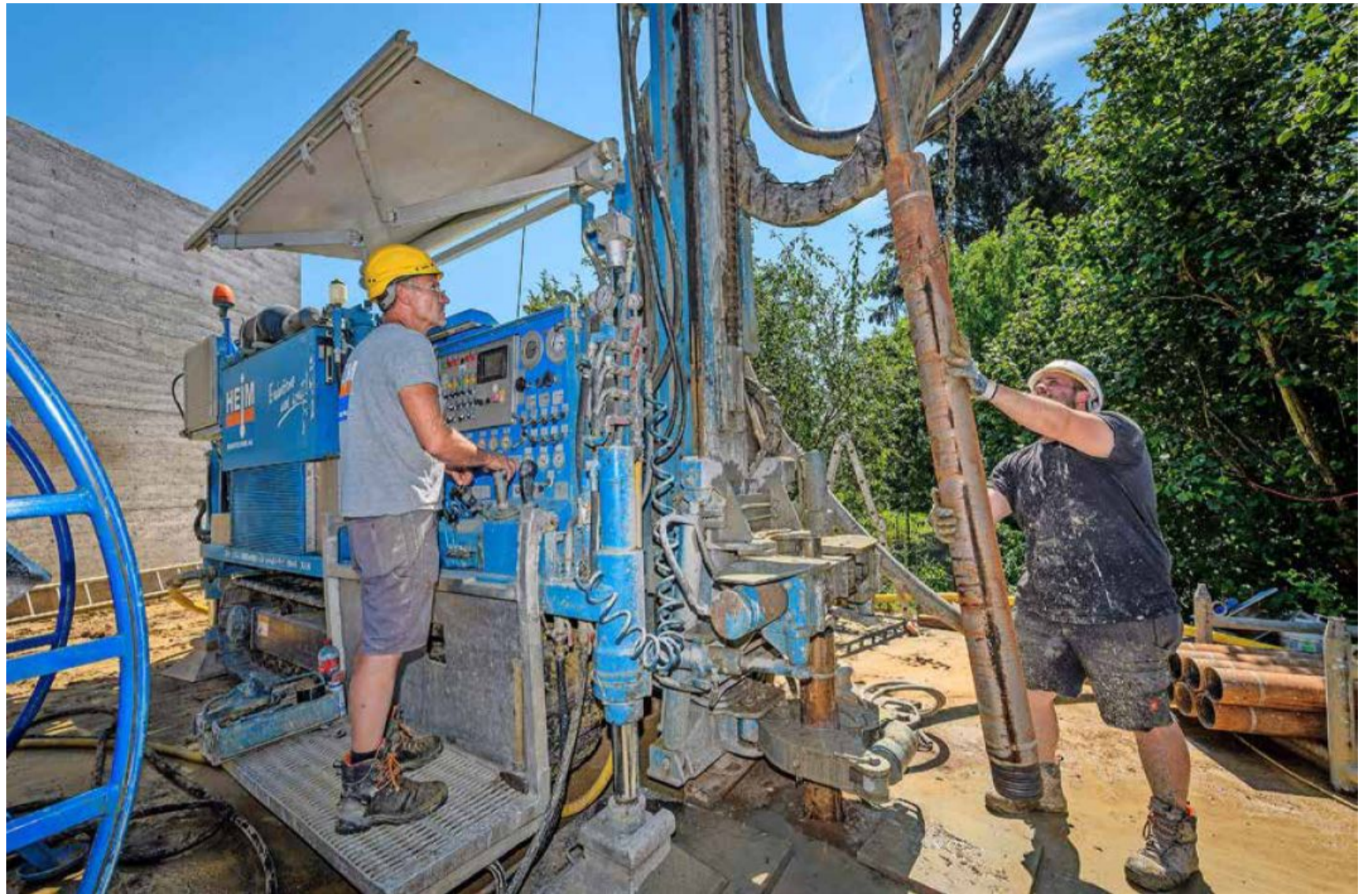
Für eine Wärmepumpe wurde im Sommer in Laufen-Uhwiesen 180 Meter in die Tiefe gebohrt. Unterdessen ist die Anlage schon zwei Monate in Betrieb.
