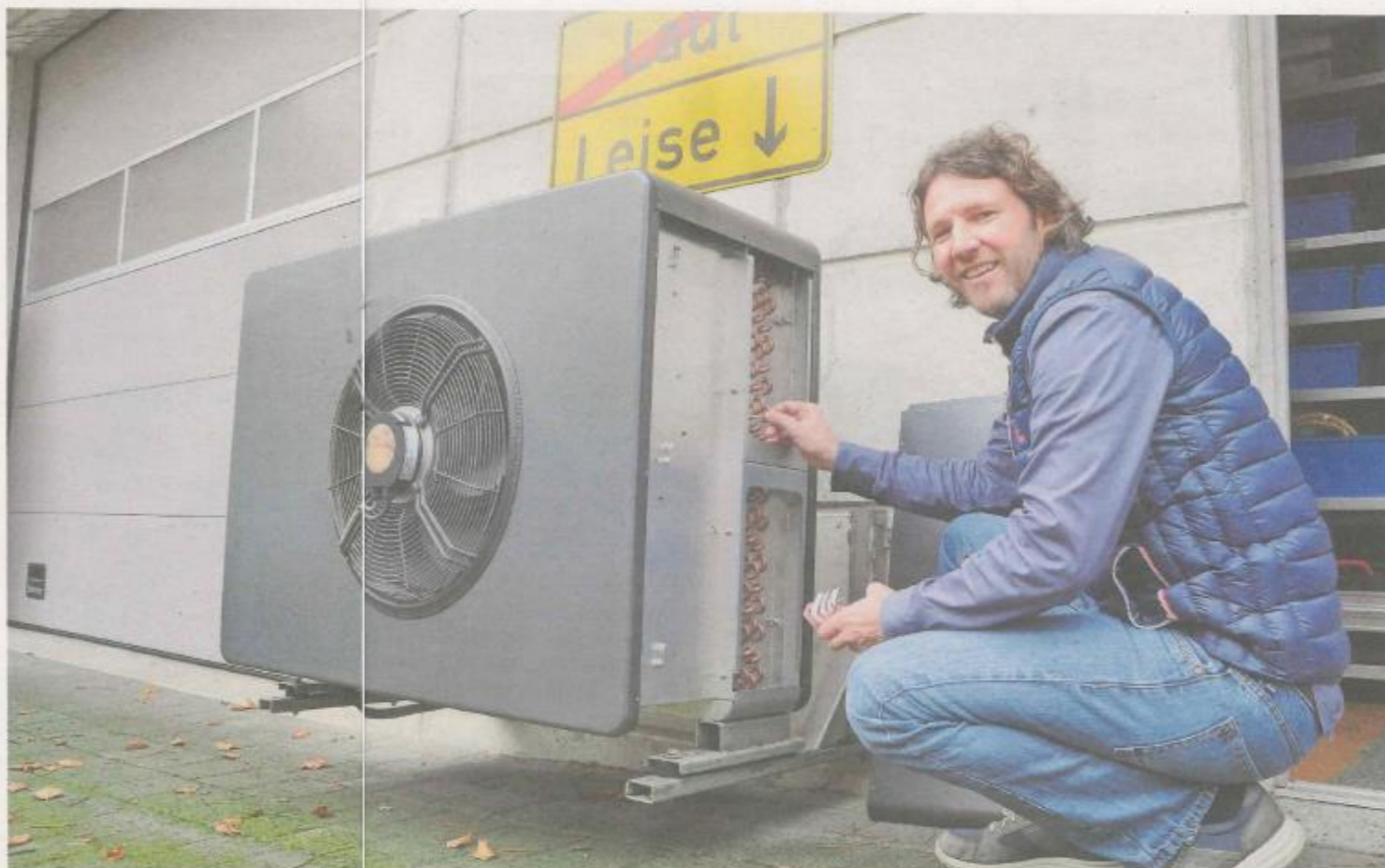
Claudio Rosset vor dem Testgerät, einer für Sanierungen geeigneten Split-Wärmepumpe, im Lager in Kleinandelfingen. Bild Mark Gasser
